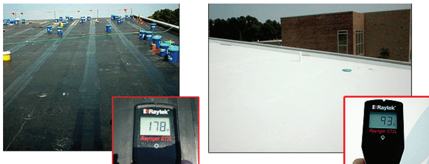
Rysunek 4. Odczyt temperatury przed (178°F/81°C) oraz po (93°F/34°C) zastosowaniu jasnego pokrycia dachowego 19
