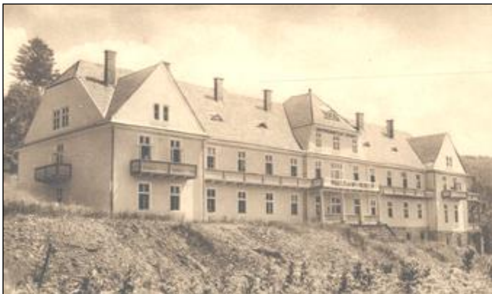
Fotografia 6. Dom Wypoczynkowy Stowarzyszenia Urzędników Kontroli Skarbowej „Gorgany” w Jamnej.
