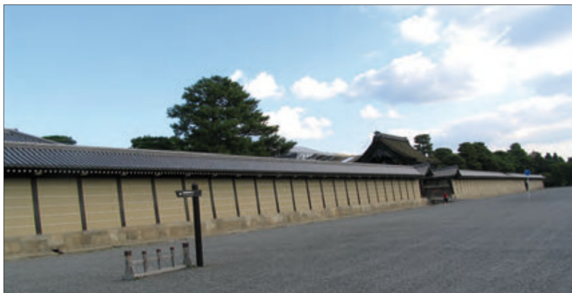
| Mur wokół Pałacu Cesarskiego, Kioto (fot. Ewa Pałasz-Rutkowska)
