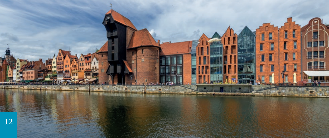
▼ Żuraw – zabytkowy dźwig portowy i jedna z bram wodnych Gdańska
