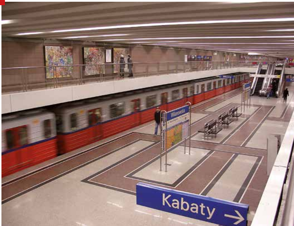
Stacja metra Wilanowska w Warszawie
