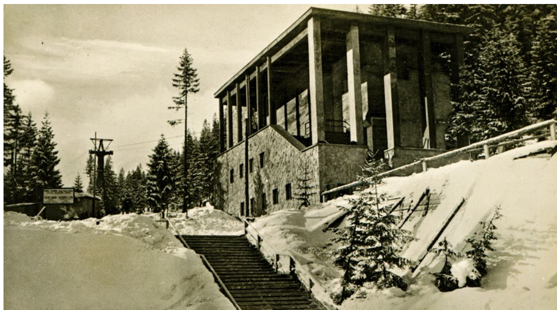
Kuznice – dolna stacja kolei na Kasprowy Wierch w 1938 r. ▲
