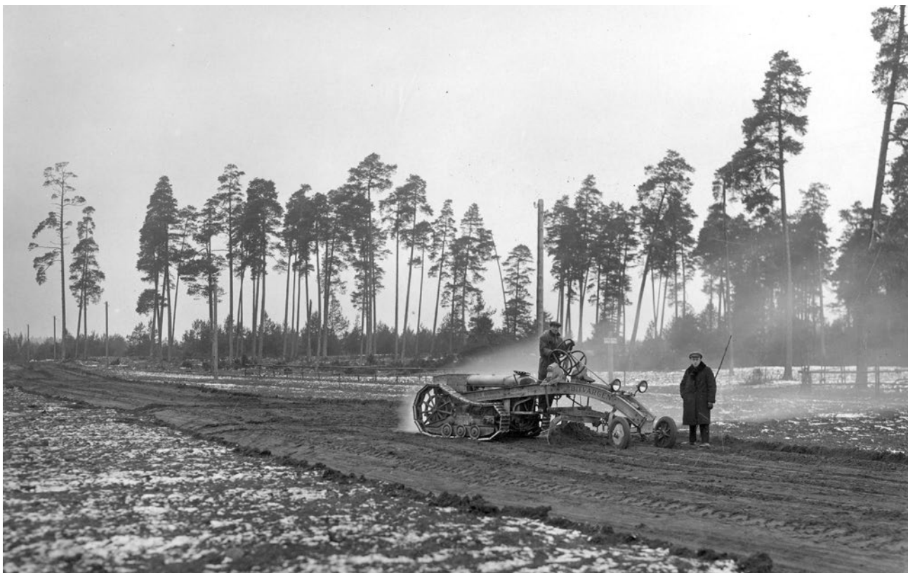
◀ Budowa drogi Nowogródek- Nieśwież (na zdjęciu widoczna maszyna wyrównująca nawierzchnię, 1928)
