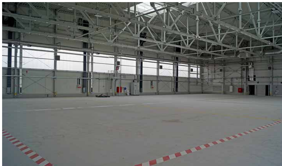
Wnętrze hangaru pozwala na postój dwóch śmigłowców wielkości AW101, zastosowane materiały i rozwiązania konstrukcyjne pozwalają nie korzystać wewnątrz ze sztucznego oświetlenia nawet w pochmurny dzień.
