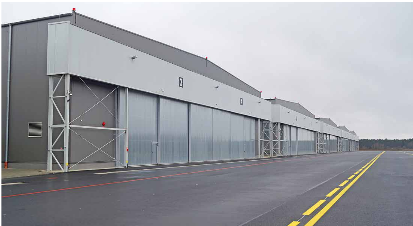
W ramach modernizacji lotniska w Darłowie postawiono sześć hangarów z 12 miejscami postojowymi średnich śmigłowców wielozadaniowych. Wraz z nimi zbudowano nową drogę kołowania i płytę postojową.
